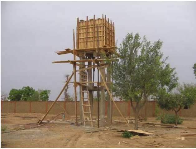
De watertoren in aanbouw
