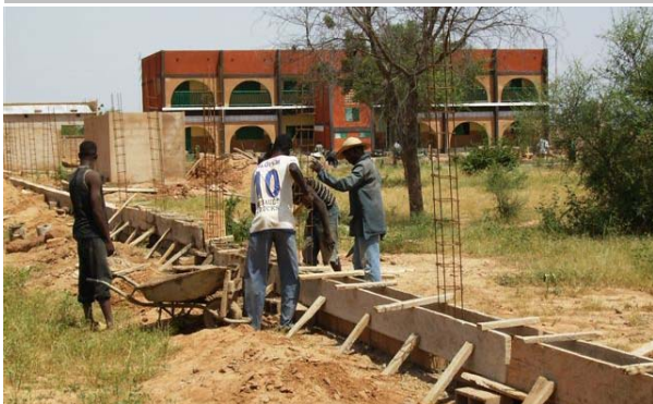
Een muur van 711 meter lang wordt om het terrein gebouwd
